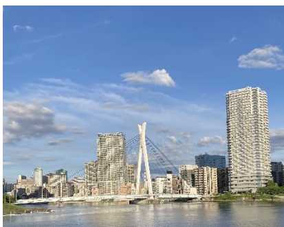
隅田川テラス (中央大橋付近)
